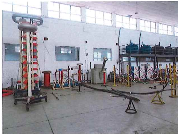
G3: 冲击电压试验 Impulse voltage test
