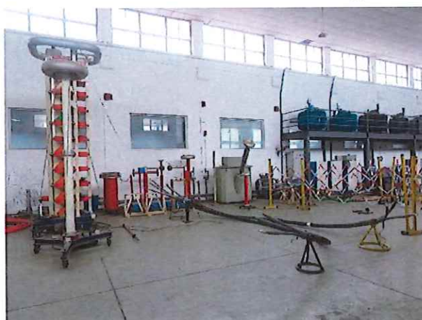
G3: 冲击电压试验 Impulse voltage test
